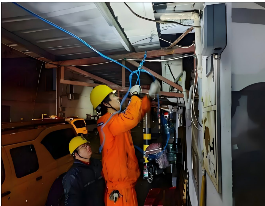
抢修班接到用户报修到现场恢复供电/任演清 摄
